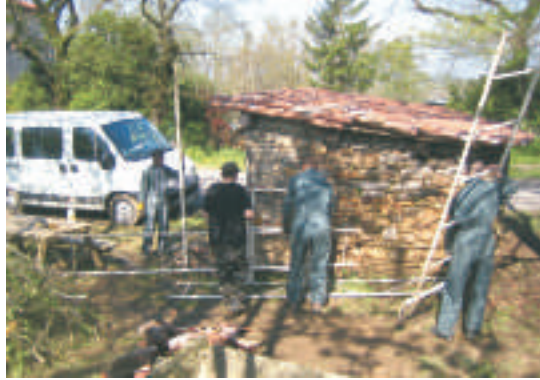
Réfection toiture du puits à Vermeils
