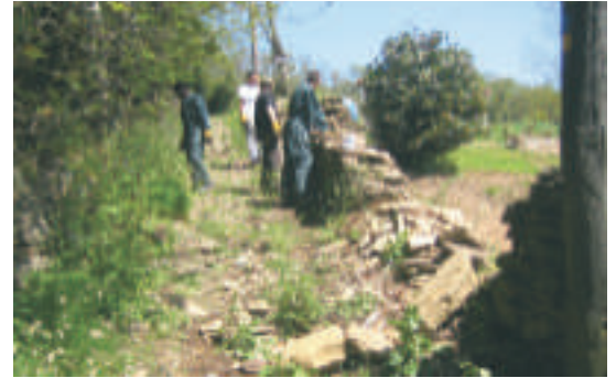
Réfection du mur en pierres sèches Chemin des vignes à Pont de l'Arn
