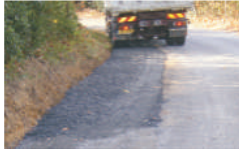
Route de Rigaud : enrochement, empierrement, renforcement des bas côtés
