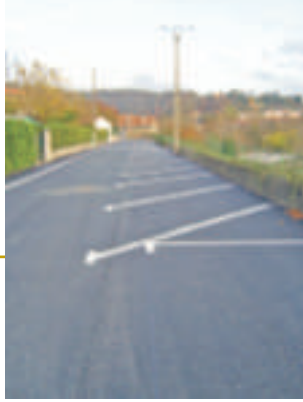
Goudronnage rue des Vignals et rue du Gué de l'Arn
