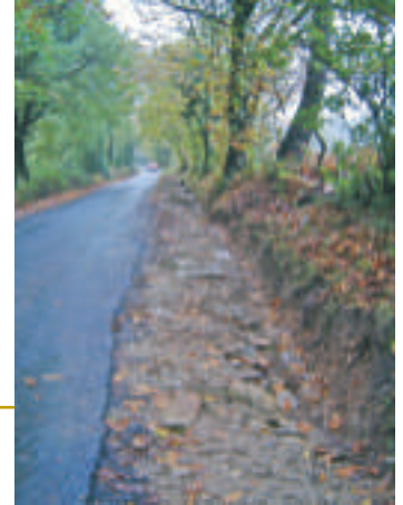
Route de Rigaud : enrochement, empierrement, renforcement des bas côtés
