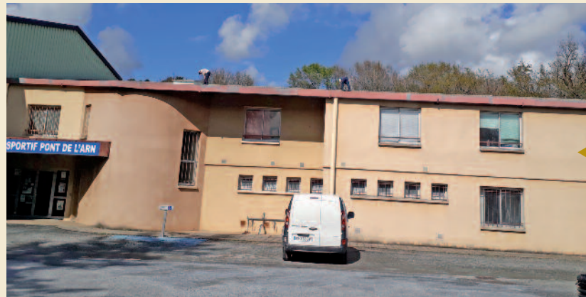
Réparation toiture tennis couvert.
