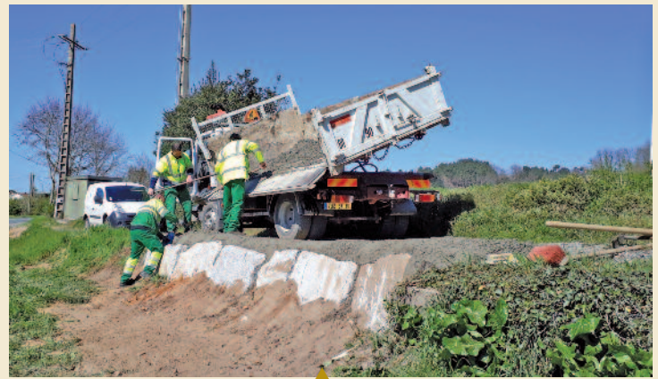
Confortement de la chaussée suite aux inondations.
