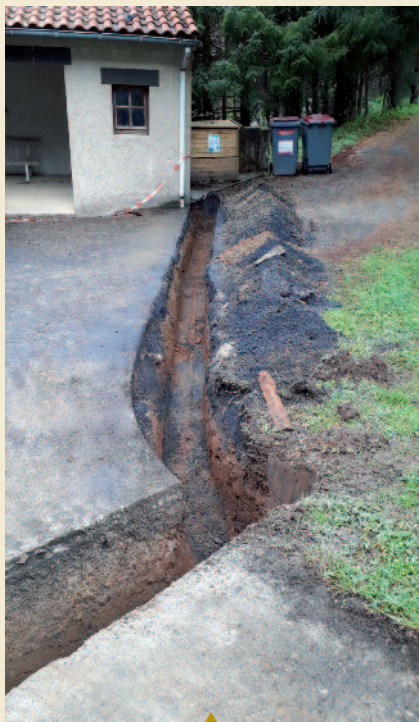
réparation fuite d'eau au cimetière.
