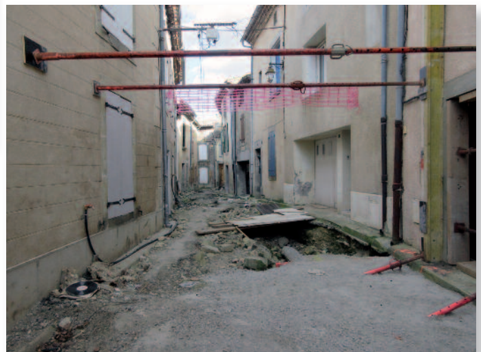
Une rue interdite et vouée entièrement à la démolition
