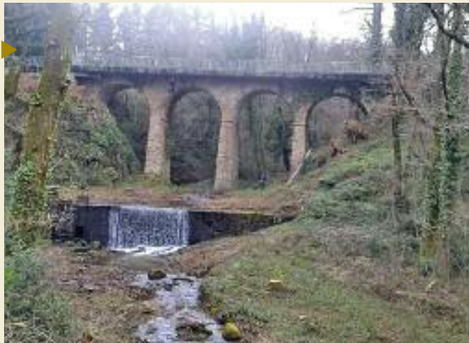
Dégagement du Viaduc de Saint-Baudille.
