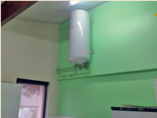
Remplacement du chauffe-eau à la salle de Rigautou
