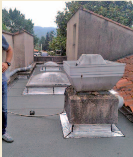
Réparation du toit à la salle de Rigautou
