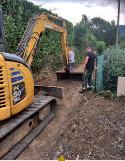
préparation de la chaussée avant goudronnage
