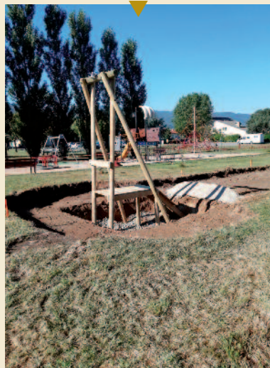
installation de la tyrolienne sur l'aire de jeu
