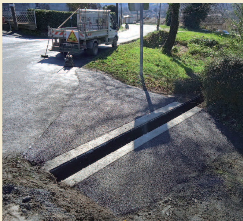
Travaux de voirie pluvial route d'Anglès
