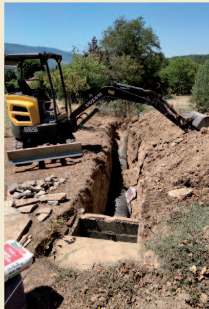
Réfection pluvial à St Baudille
