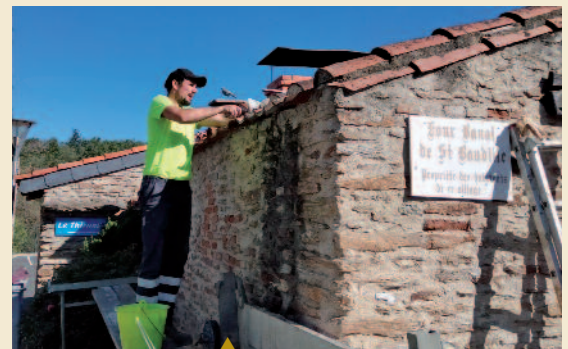
Réfection toiture four à pain banal de St Baudille
