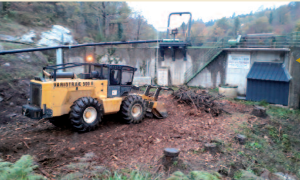
Broyages de branches au barrage du Bouyssou
