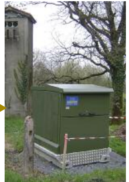
Dépose de certaines lignes aériennes et mise en place de nouveaux postes de transformation.
