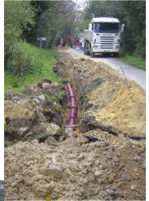
Enfouissement des lignes électriques à Pomarède.
