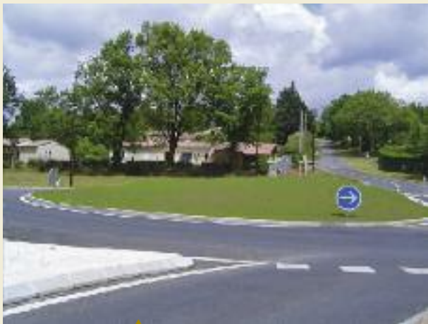
Le rond point de Vermeils terminé.
