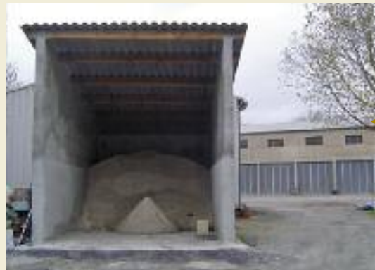
Finalisation des travaux du box à sel
