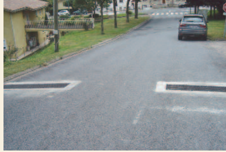
Installation d'une grille rue du Parc des Sports pour favoriser l'écoulement des eaux de ruissellement.
