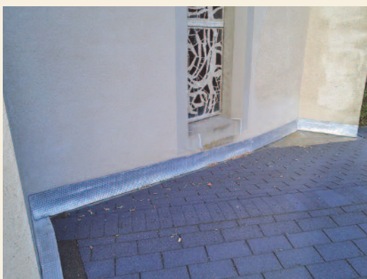
Réfection de la toiture de l'église de Pont de l'Arn.
