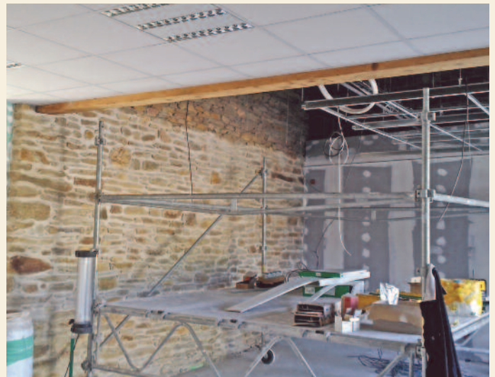
Aménagement de la salle de la Môle
