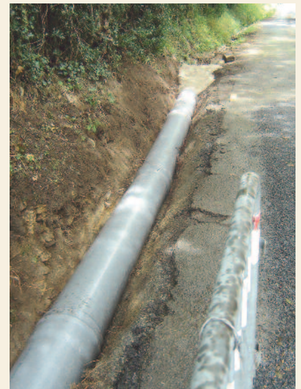
Remise à neuf du réseau pluvial à Pomarède
