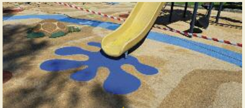
réparation du sol de l'aire de jeu derrière la mairie
