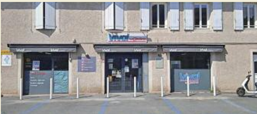
Poteaux sécurité devant le magasin "Vival"
